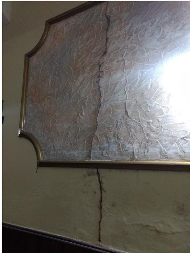
Figura 2 – Rachadura gerada por infiltração.
