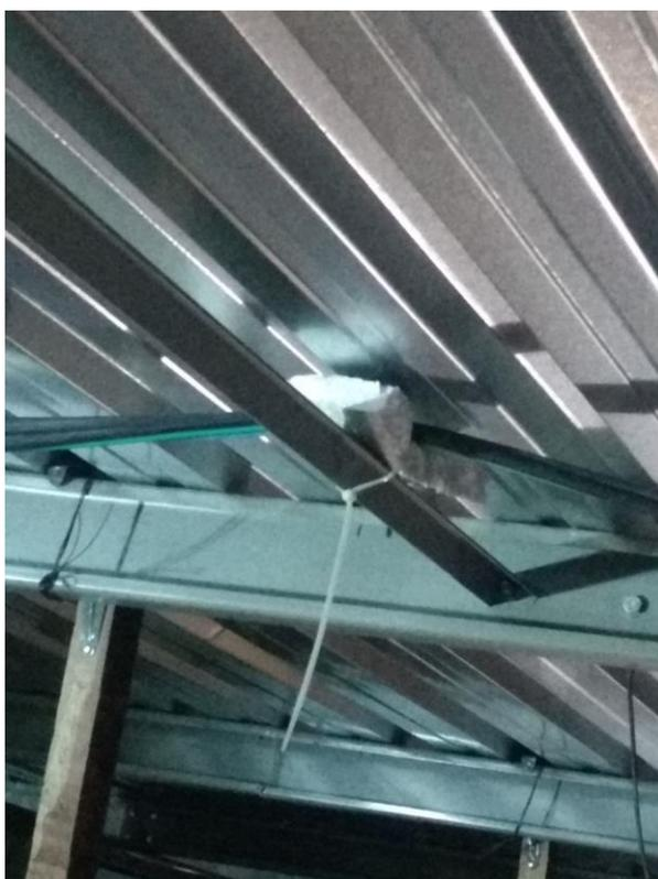
Figura 9 – Isolamento de cabos de alta tensão com isopor.
