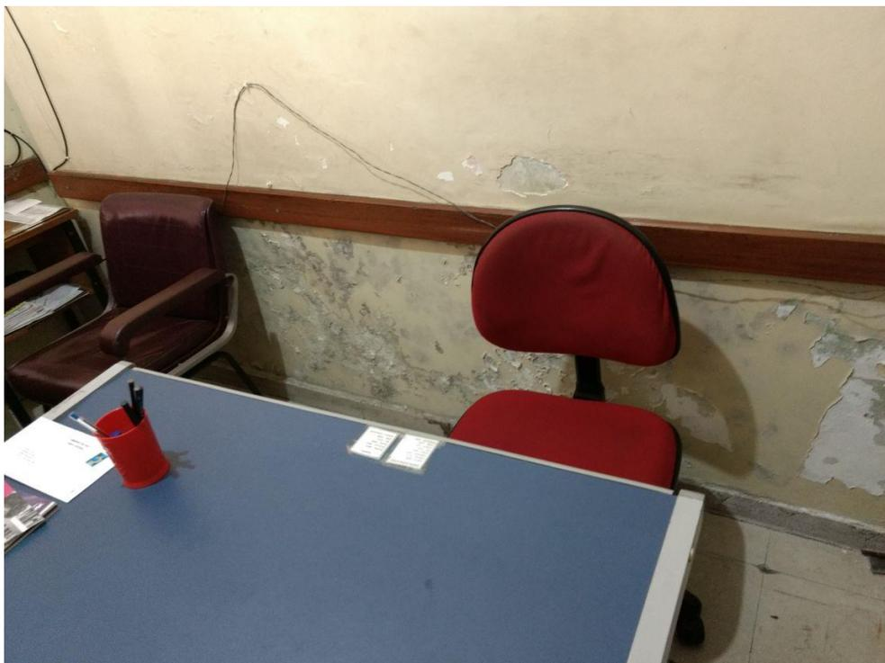
Figura 3 – Infiltração na sala da direção.
